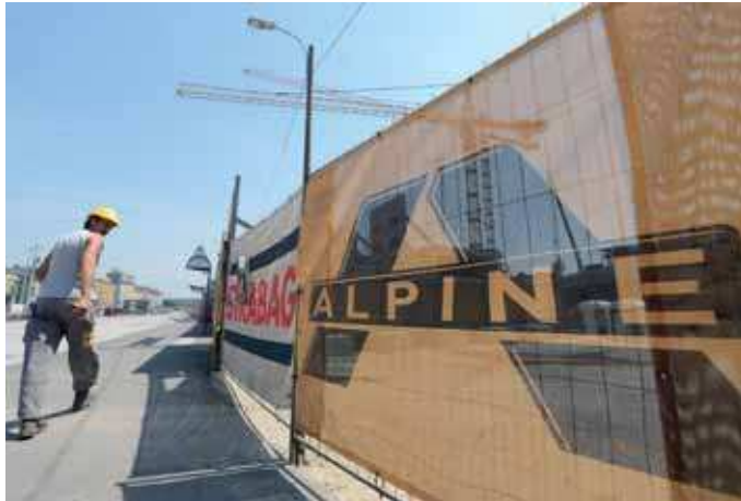
Derzeit stehen die meisten der 1400 Alpine-Baustellen still. Nächste Woche soll weitergebaut werden. Foto: APA/Fobringer
