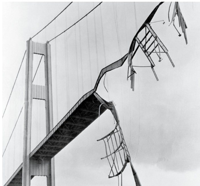
Ein oft zitiertes Beispiel für Resonanzen, die Tacoma-Narrows-Bridge: sie wurde am 7. November 1940 von mäßigem Wind so heftig in Schwin- gung versetzt, dass sie innerhalb einer Stunde einstürzte.
